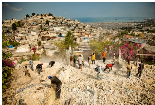
Die zerstörte MEVA, Schule von Haiti Care
